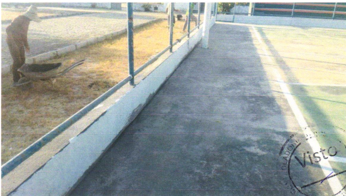
Foto 06 - PISO EM CONCRETO 20 MPA PREPARO MECÂNICO, ESPESSURA 7CM. AF_09/2020
