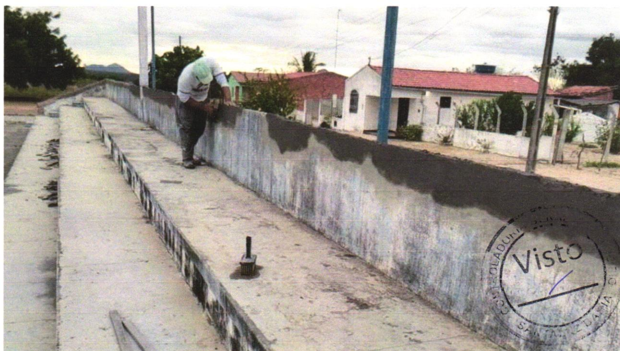
Foto 04- MASSA ÚNICA, PARA RECEBIMENTO DE PINTURA, EM ARGAMASSA TRAÇO 1:2:8, PREPARO MANUAL, APLICADA MANUALMENTE EM FACES INTERNAS DE PAREDES, ESPESSURA DE 10MM, COM EXECUÇÃO DE TALISCAS
